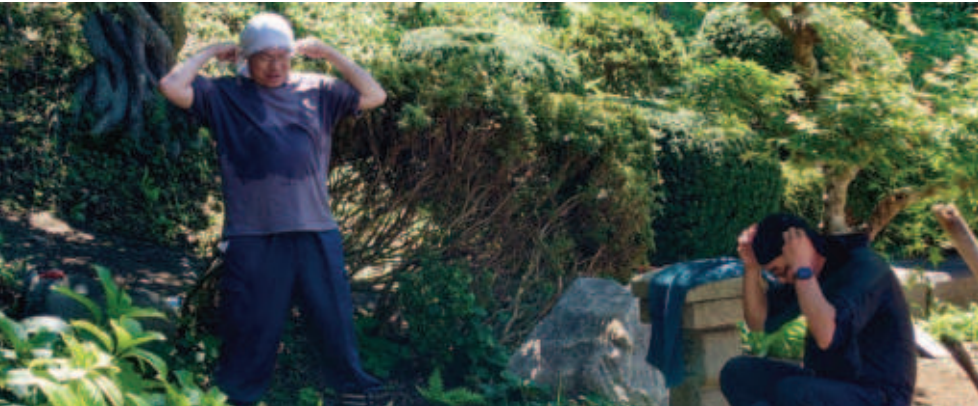
・宗得寺 本堂裏での土砂の運搬・撤去作業。
